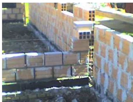
Construcción de la escuela
